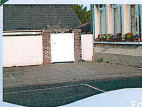
Ecole : Changement des portillons Sortie de l'Ecole et Cour/Cantine
